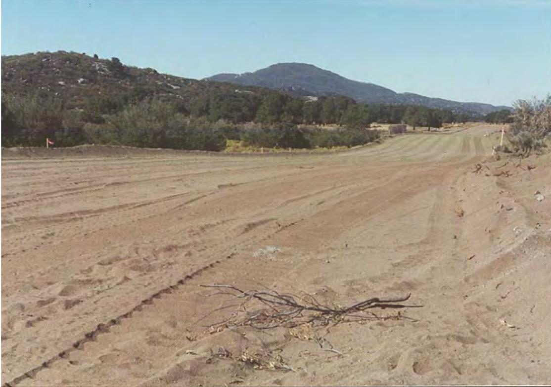
Figura 5. Vista del camino construido para el paso de maquinaria y equipo técnico para la construcción del gasoducto Baja Norte.
